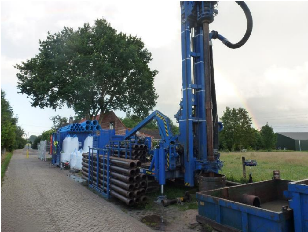
Figuur 6. Voorbeeld van een boorinstallatie voor het plaatsen van een brandput.
